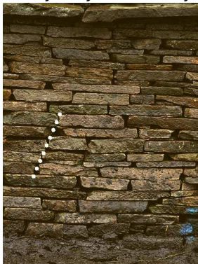
Ffig.25. Uniad rhedeg croeslinol (chwith o'r canol) mewn wal dywodfaen
