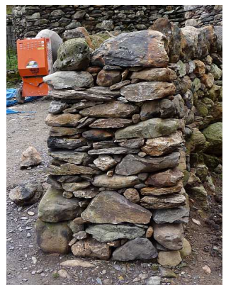
Ffig.56. Golwg o'r pen ac o'r ochr o derfyniad o "blethwyr toredig" wedi'i blethu'n wael a heb ddigon o oled.
