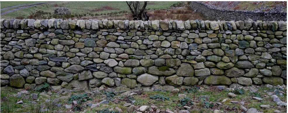
Fig.16. Uchod ac isod, waliau ar ddwy ochr yr un cae wedi'u codi o gerrig rhewlifol ar ôl clirio'r cae. Mae'r wal uchod wedi'i chodi gan rai dan hyfforddiant a'r wal isod gan Brif Grefftwr
