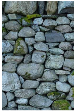
Ffig.26. Uniad rhedeg croeslinol (canol) mewn wal o gerrig maes rhewlifol
