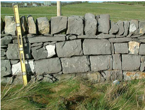
Ffig.4. Cerrig mwy na'r arfer wedi'u gosod yn uchel mewn wal. calchfaen carbonifferaidd
