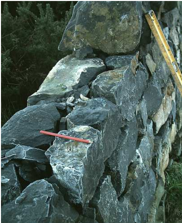
Ffig.33. Brasgamwyr ar eu hymylon. O edrych ar y bensel, gellir gweld bod hyd y garreg i mewn i'r wal yn llai na'i huchder yn yr wyneb.
