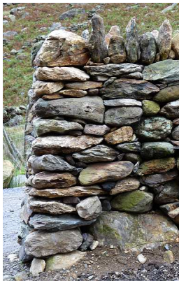
Ffig.56. Golwg o'r pen ac o'r ochr o derfyniad o "blethwyr toredig" wedi'i blethu'n wael a heb ddigon o oled.
