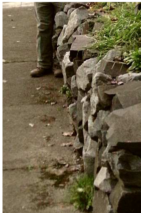
Ffig.38. Mae boch fawr yn ddiffyg yn y llinell a'r goledd
