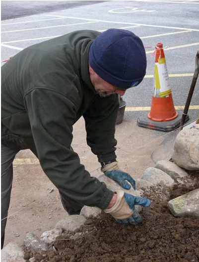
Fig.28. Defnyddio pridd o amgylch y ei chynffon i ddal y garreg yn unionsyth
