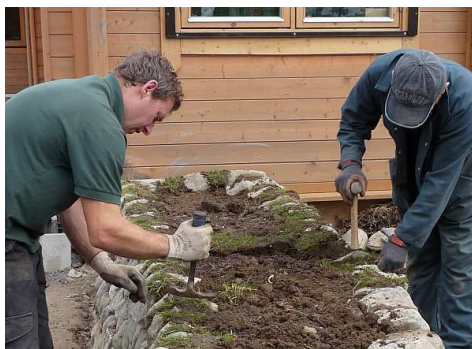
Ffig.38. Darnau bach o dyweirch yn cael eu gwthio i mewn i'r uniadau ar y cwrs uchaf cyn gosod y tyweirch terfynol
