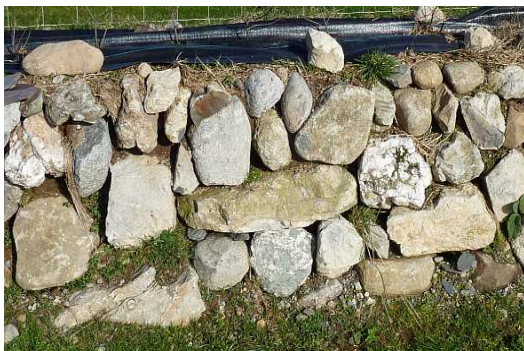
Ffig.12. Dde. Carreg wastad wedi'i rhoi i orwedd ar gerrig fertigol, gan greu gwendid strwythurol
