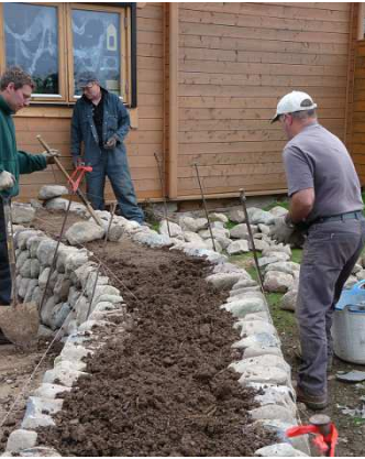
Ffig.20. Pridd rhydd ar y craidd cywasgedig yn barod ar gyfer y cwrws nesaf
