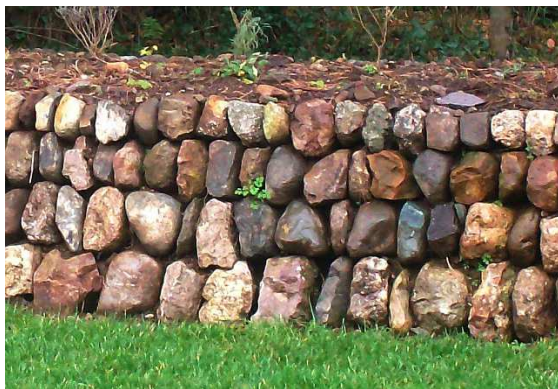
Ffig.25. Cerrig onglog a cherrig ar ffurf blociau yn creu clawdd tynn sydd â bylchau bach, ond cyswllt da rhwng y naill garreg a'r llall. Cymharer â Ffig.1, sydd â cherrig llai a theneuach a'r nesaf peth i ddim o fylchau.
